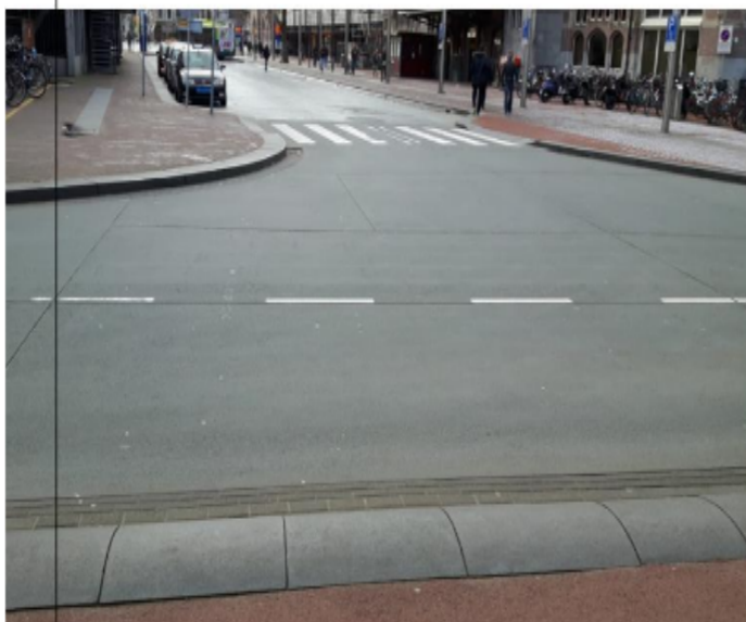
▲ Surenkamos įdėklais sujungtos betono dangos pavyzdys „ModieSlab“ sistema (Harteme, Olandijoje).
