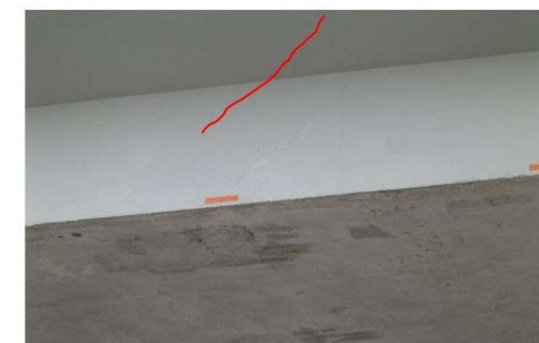
Įs kairės: 1.6 pav. Atsivėrę įstrižieji plyšiai; 1.7 pav. Sijų sienutėse atsivėrę įstrižieji plyšiai
