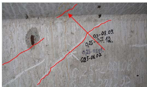
Įs kairės: 1.6 pav. Atsivėrę įstrižieji plyšiai; 1.7 pav. Sijų sienutėse atsivėrę įstrižieji plyšiai
