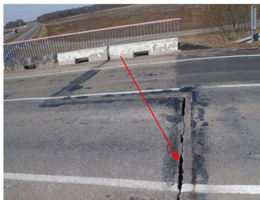
Įs kairės: 1.2 pav. Kiauri viadukų deformaciniai pjūviai virš pirmos atramos; 1.3 pav. Nelygi, banguota, nusidėvėjusi kelio danga
