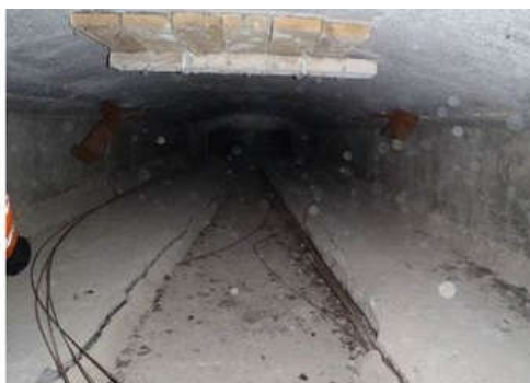
Įs kairės: 1.4 pav. Nesandari blokų sandūra; 1.5 pav. Viadukuose koroduoja vielapluoščiai, dalis jų nutrūkė
