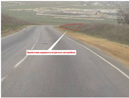
Рис. 3. Пример обнаруженной ограниченной пространственной видимости на участке автомобильной дороги (радиус кривой=1000 м, продольный уклон – 7‰)
