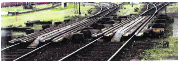
6 pav. Dvibėgis sijinis pneumatinis stabdiklis (Mannheim, Vokietija) (Theeg et al. 2009)
