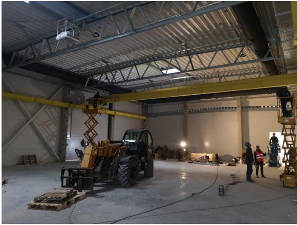
3 pav. Pokraninis kelias ir kranas sija iš sinusoidinių sijų Kauno Laisvojoje Ekonominėje Zonoje.
