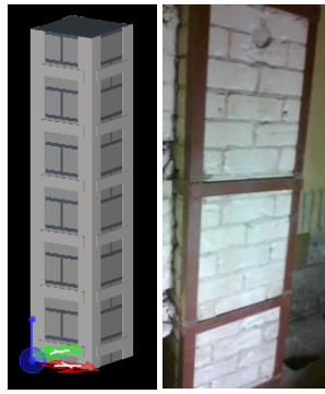
1 pav. Kolonos sustiprintos naudojant plieninių kampuočių apvalkalą
