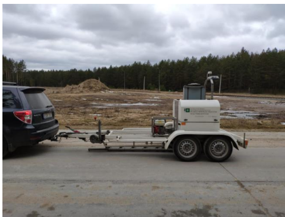
2.8 pav. Laikomosios gebos matavimai vietinės reikšmės kelyje Nr. 130 Fig. 2.8. Bearing capacity measurements on local road No. 130
